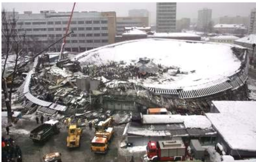
Рис. 1. Здание Басманного рынка после обрушения
