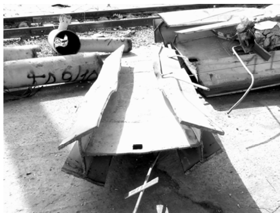
Рис. 3. Фрагмент колонны каркаса здания
